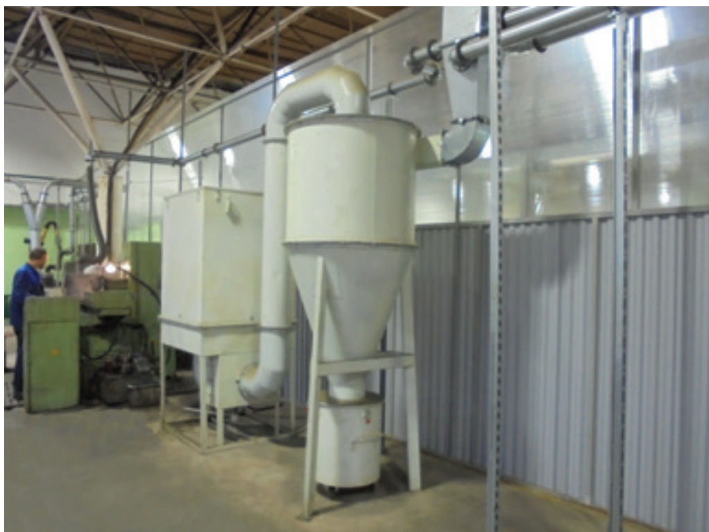
Рис. 1.4. Фильтр ФВА-М-2000 с циклоном для очистки воздуха от туманов масел и эмульсий, установленный на АО «Лыткаринский завод оптического стекла».
