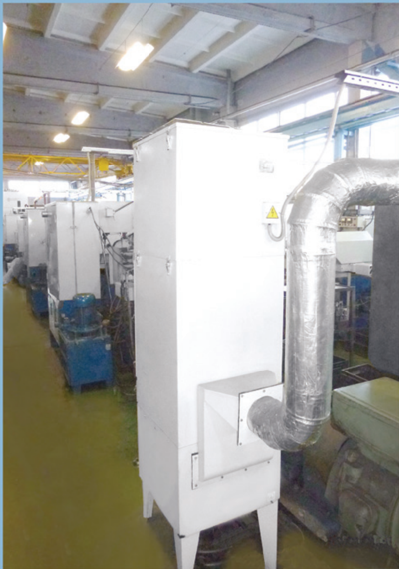
Фильтры ФВА-М-750. Очистка аспирационного воздуха от масляных туманов. АВТОВАЗ
